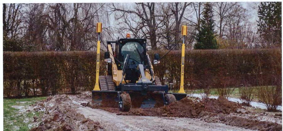
Maschinenvorführung an der Bodenschutztagung: Raupenlader mit 5t Einsatzgewicht, ausgestattet mit zwei Lasersteuergeräten für den Sportplatzbau.
